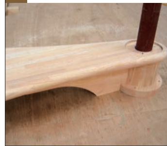
3 最下の段から取り付け
