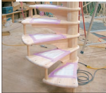
5 段板・支柱ブロックを交互に取り付け
