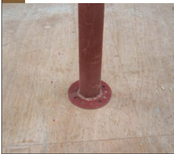
1 中心点に支柱取り付け
