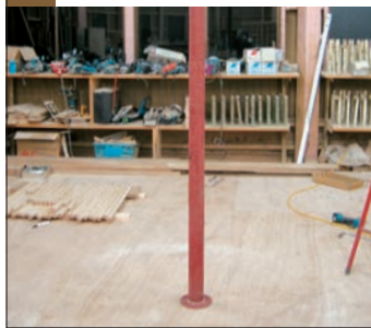
2 中心点に支柱取り付け
